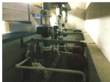
Obr. 8 Po aplikaci nátěrem ADITIZOL BASIC Obr. 9 Po aplikaci nátěrem ADITIZOL BASIC
