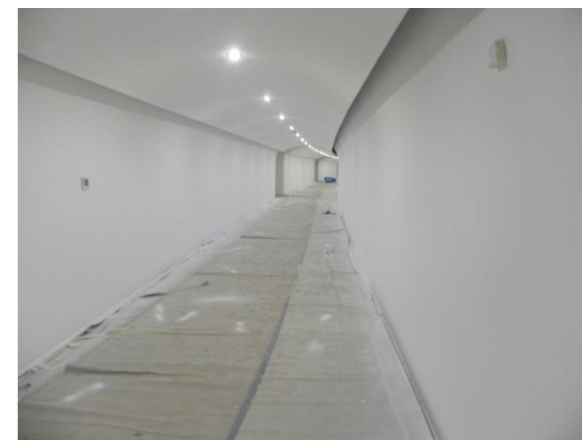
Interiér – podzemní chodba - Bratislavský hrad
