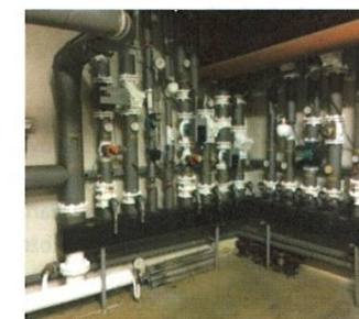
Obr. 5 Po aplikaci nátěrem ADITIZOL BASIC
