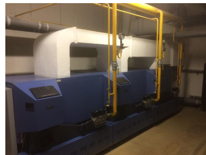
Komín spalinových cest
