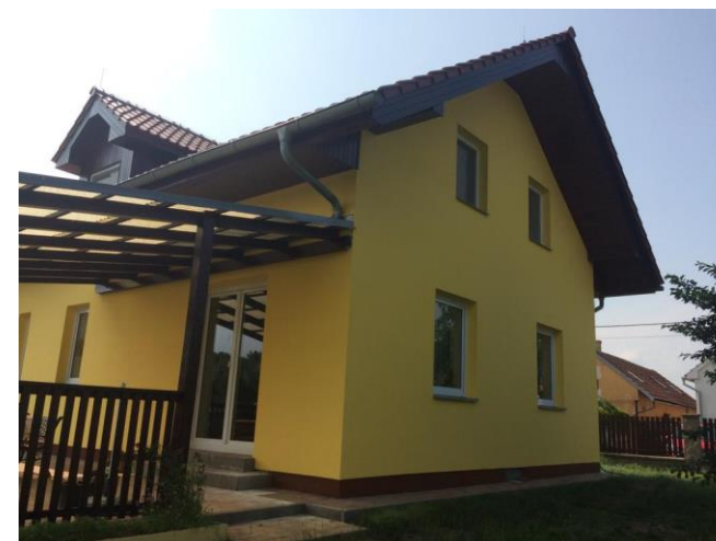
Fasáda – RD - Neratovice
