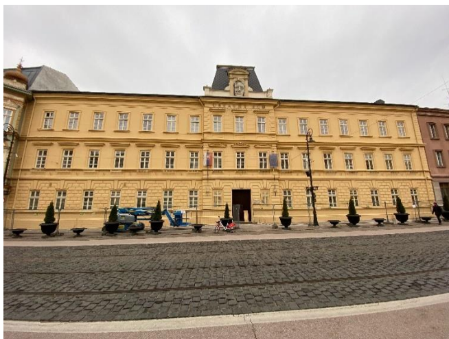
Fasáda – Ústavní soud SR - Košice
